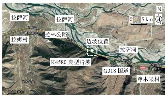
图 1 边坡位置 Fig.1 Slope location
